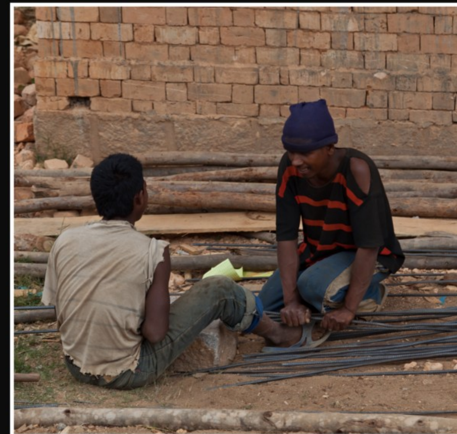
Hausbau in Madagaskar ... ohne Maschinen und Stress, mit einfachen Hilfsmitteln und ... fröhlichen Arbeitern.
